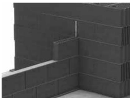
При соединении перегородки с несущей стеной на торцы блоков **Porotherm 12** нанесите раствор, уложите их и прижмите к несущей стене. При таком типе стыка необходимо укреплять каждый второй постельный шов с помощью плоского анкера из нержавеющей стали (например, с помощью анкера FD KSF компании «Фишер» (FISCHER)). Согнутую под прямым углом горизонтальную часть анкера нужно вдавить в раствор постельного шва, а вертикальную часть – прикрутить с помощью шурупа и дюбеля к несущей стене.
