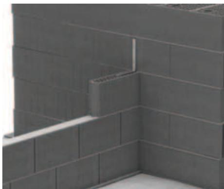
При соединении перегородки с несущей стеной на торцы блоков **Porotherm 8** или **Porotherm 12** нанесите раствор, уложите их и прижмите к несущей стене. При таком типе стыка необходимо укреплять каждый второй постельный шов с помощью плоского анкера из нержавеющей стали. Согнутую под прямым углом горизонтальную часть анкера нужно вдавить в раствор постельного шва, а вертикальную часть – прикрутить с помощью шурупа и дюбеля к несущей стене.
